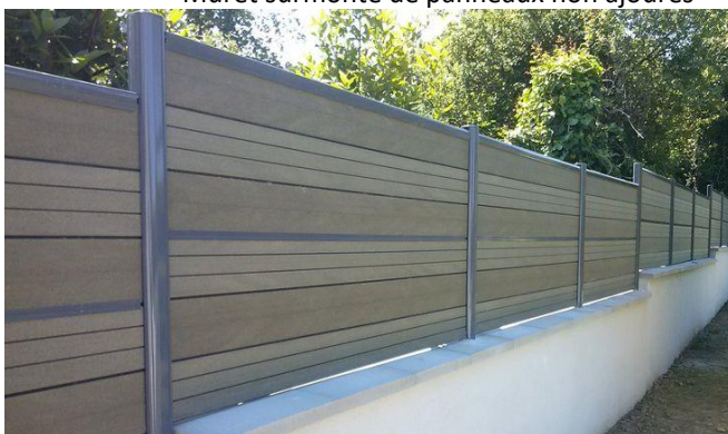
Muret surmonté de panneaux non ajourés
