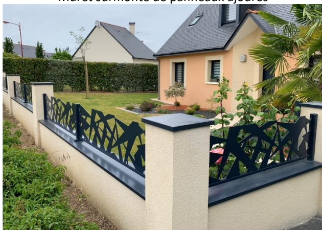
Muret surmonté de panneaux ajourés
